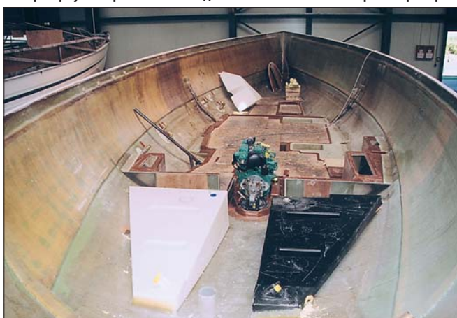
Оборудование монтируется в секции корпуса еще до установки палубы
