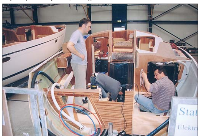
На монтаже оборудования — бригада наших бывших сограждан
